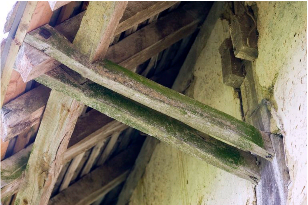
Les Bommeries : détail du toit de la grange.
