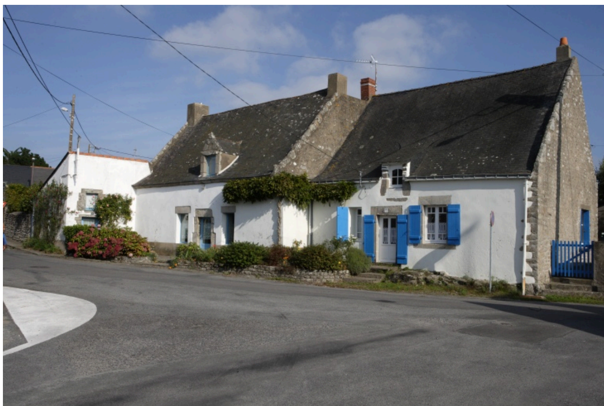
Vue d'ensemble de la rangée depuis l'ouest.
