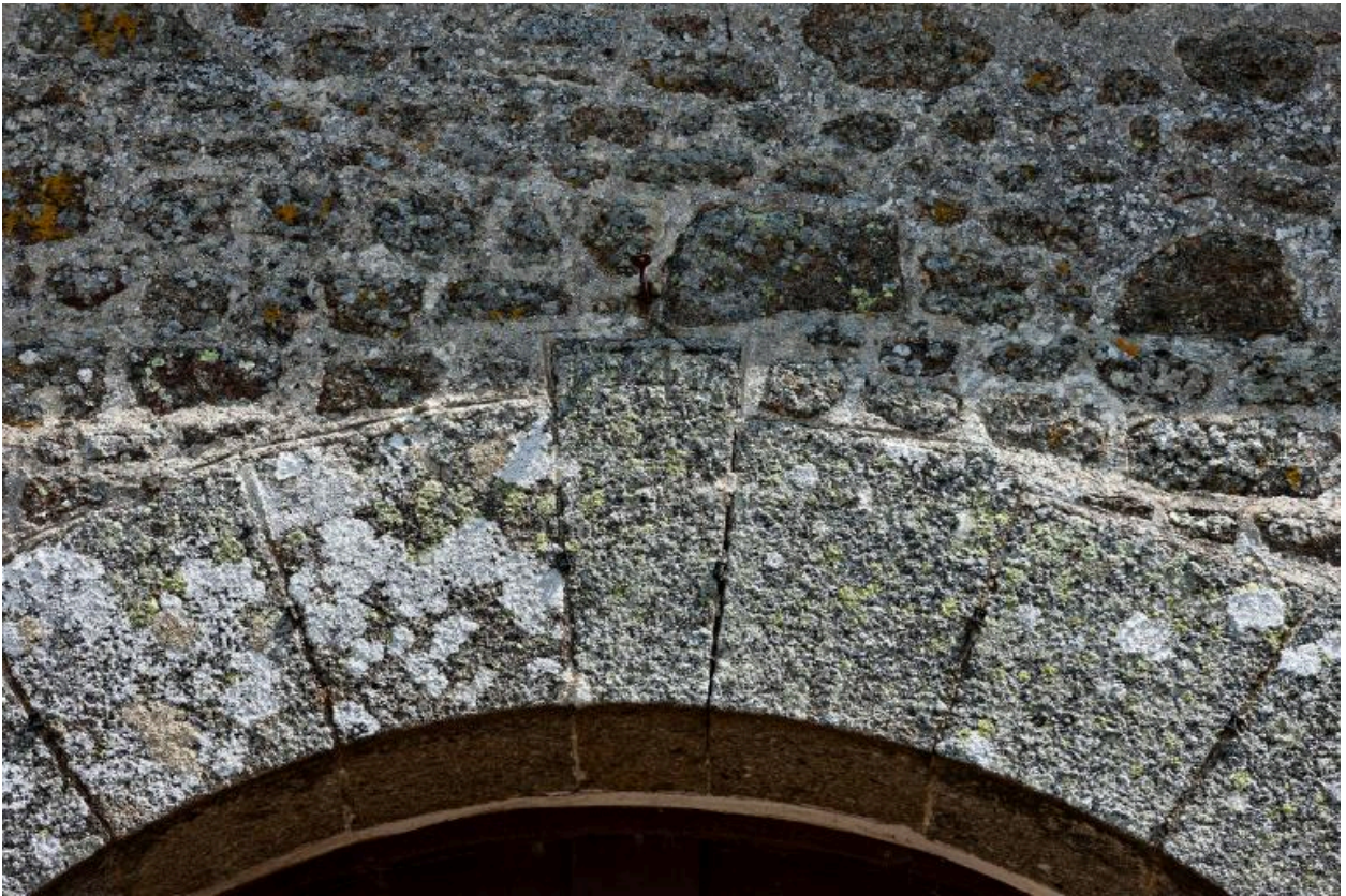
Façade occidentale : la clef de l'arc de la porte avec la date portée 1747.
