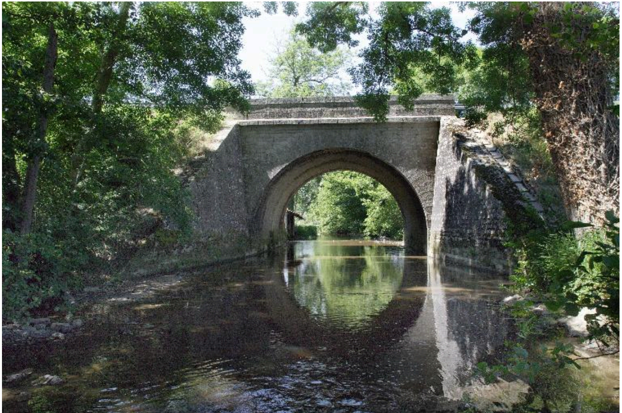
Vue depuis l'aval.
