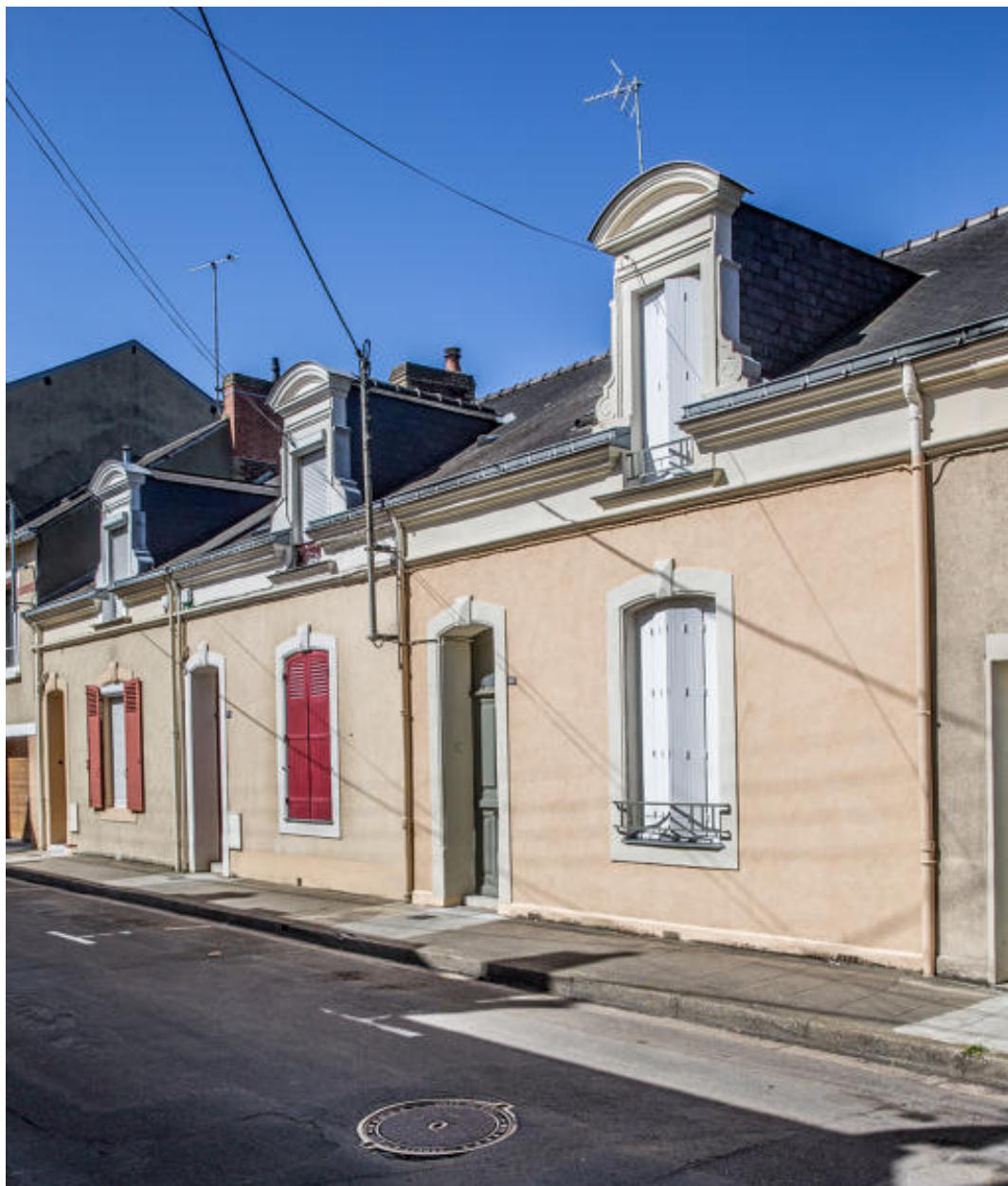
Vue d'un alignement de mancelles rue Hoche.
