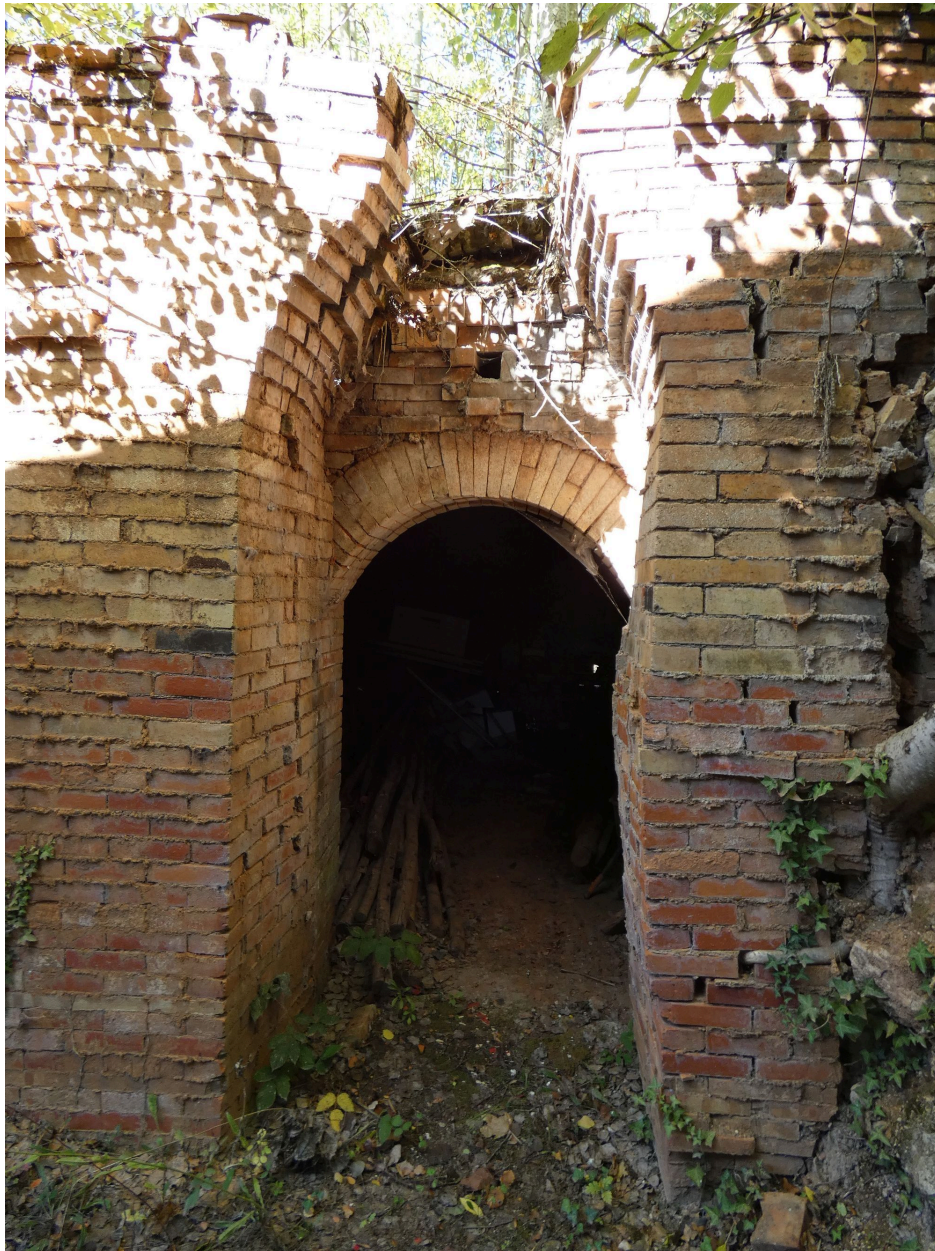
La porte d'enfournement du premier four, à l'ouest, vue depuis le sud.
