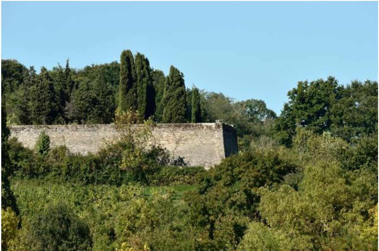
Vue de la terrasse depuis le sud.
