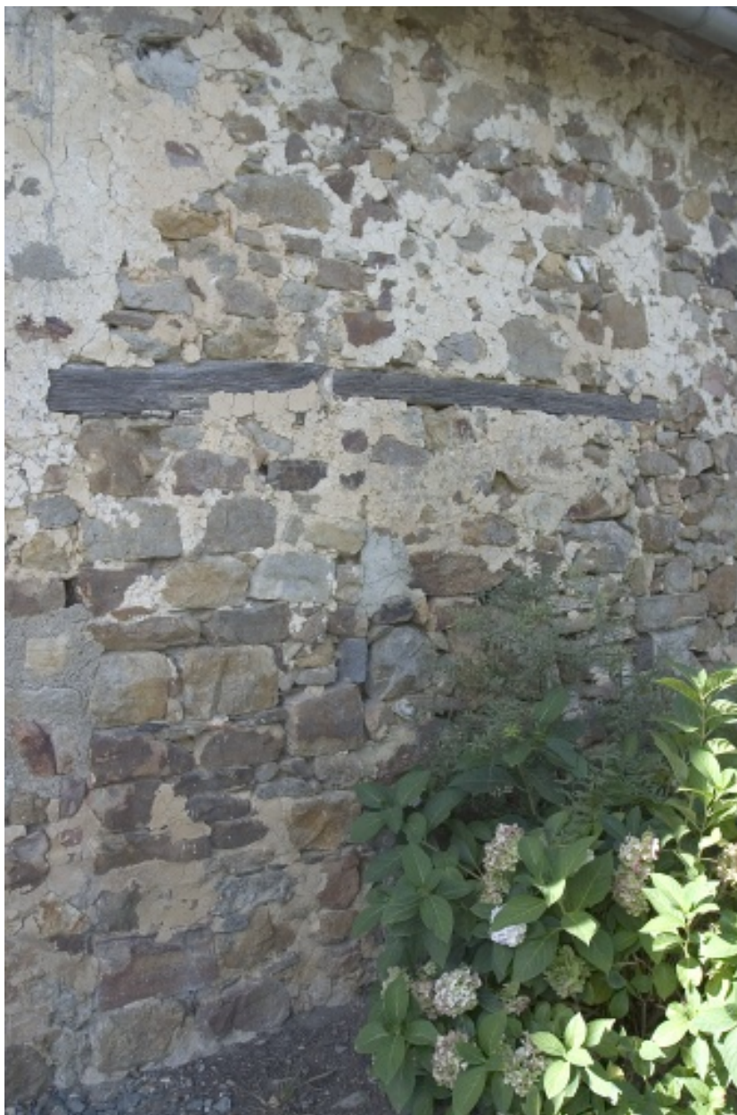
Porte bouchée sur la façade principale du logis.
