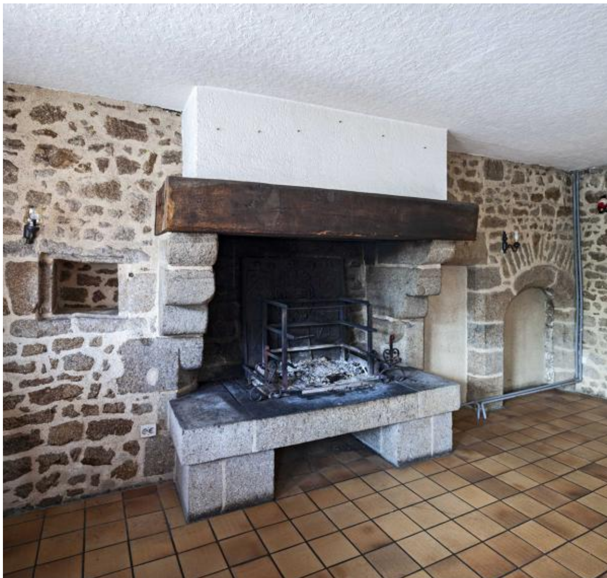
2-4 place du 8-Mai-1945, cheminée et portes du mur de refend.
