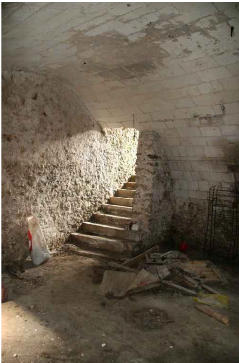
Sous-sol du château démolì.
