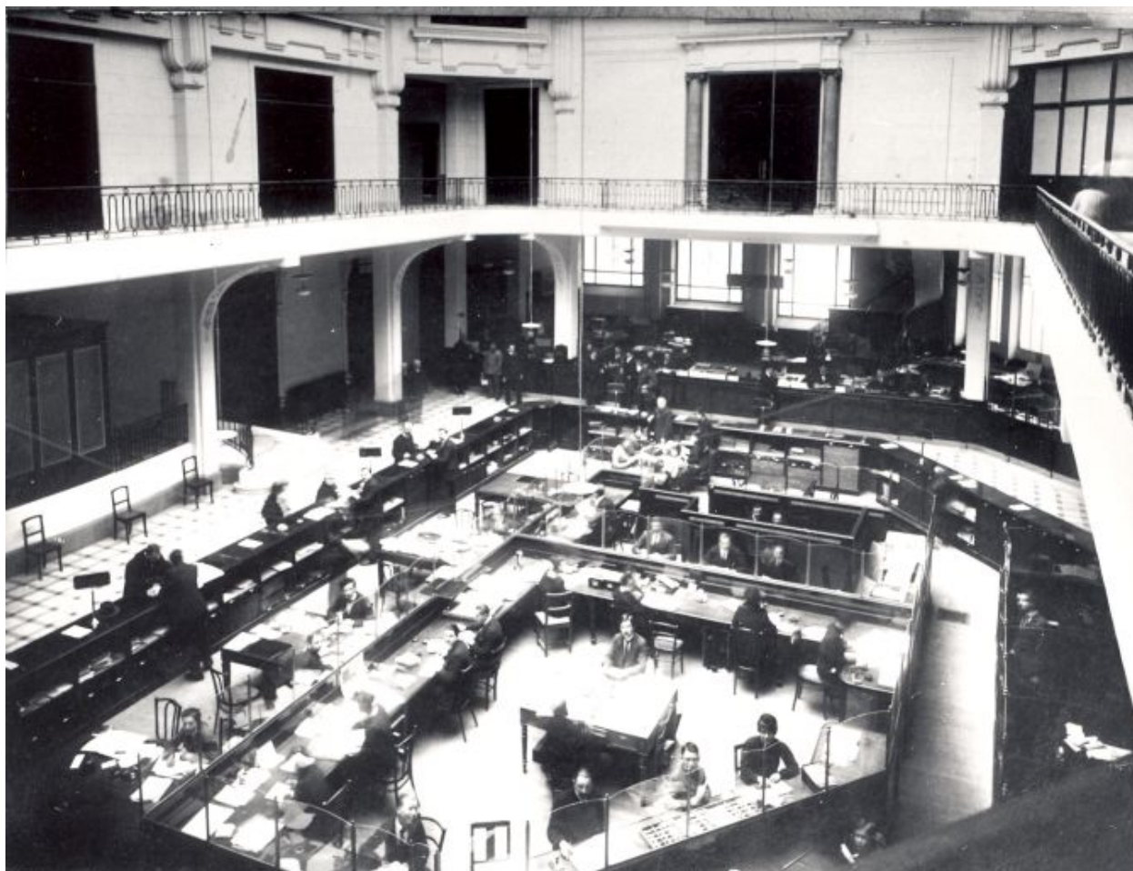
Vue d'ensemble du hall, avec les élévations antérieure et latérale gauche, fotogr., [v. 1922].
