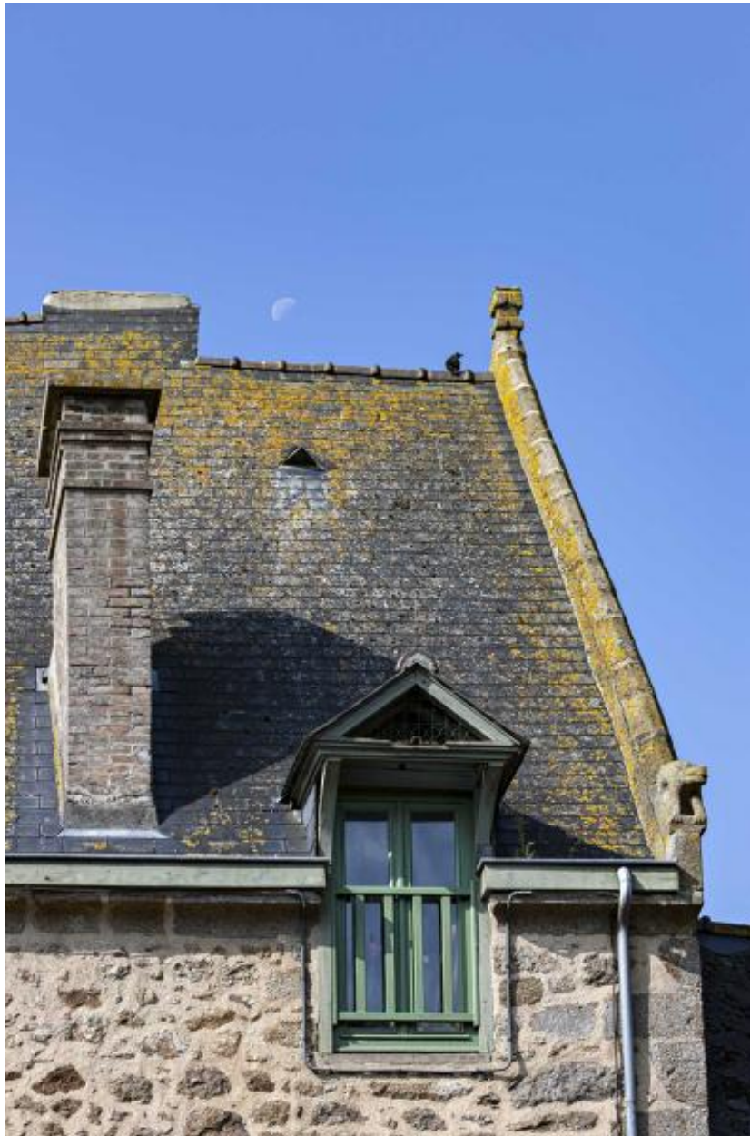
Ancien hôtel particulier, 31-33 rue Dorée. Rampant du pignon ouest.
