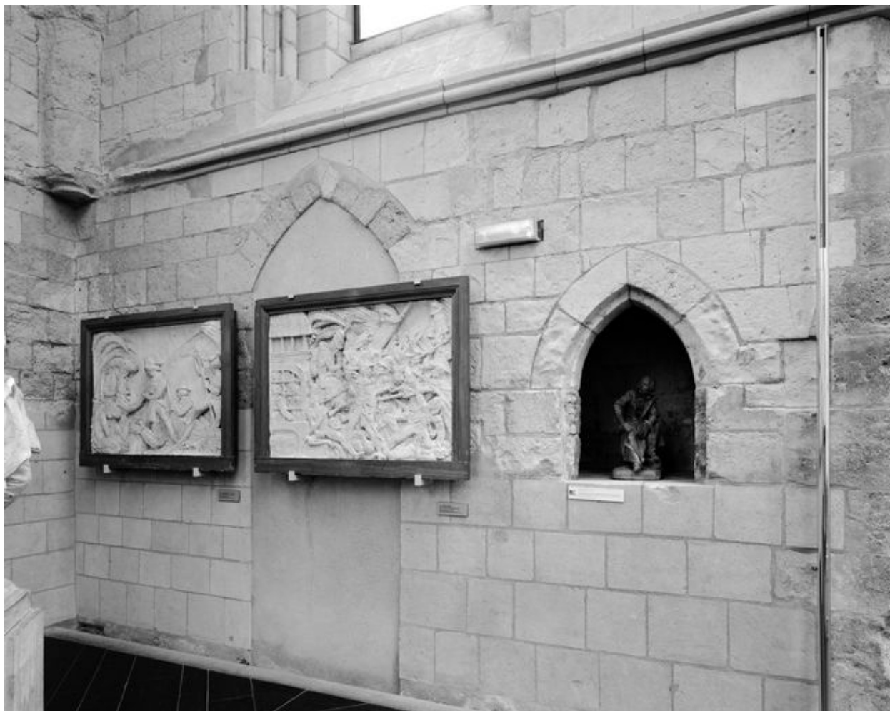
Abbatiale, bras sud du transept, élévation ouest : niveau inférieur.
