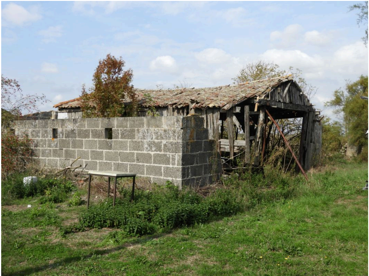
Ancien hangar en bois au nord du logis.
