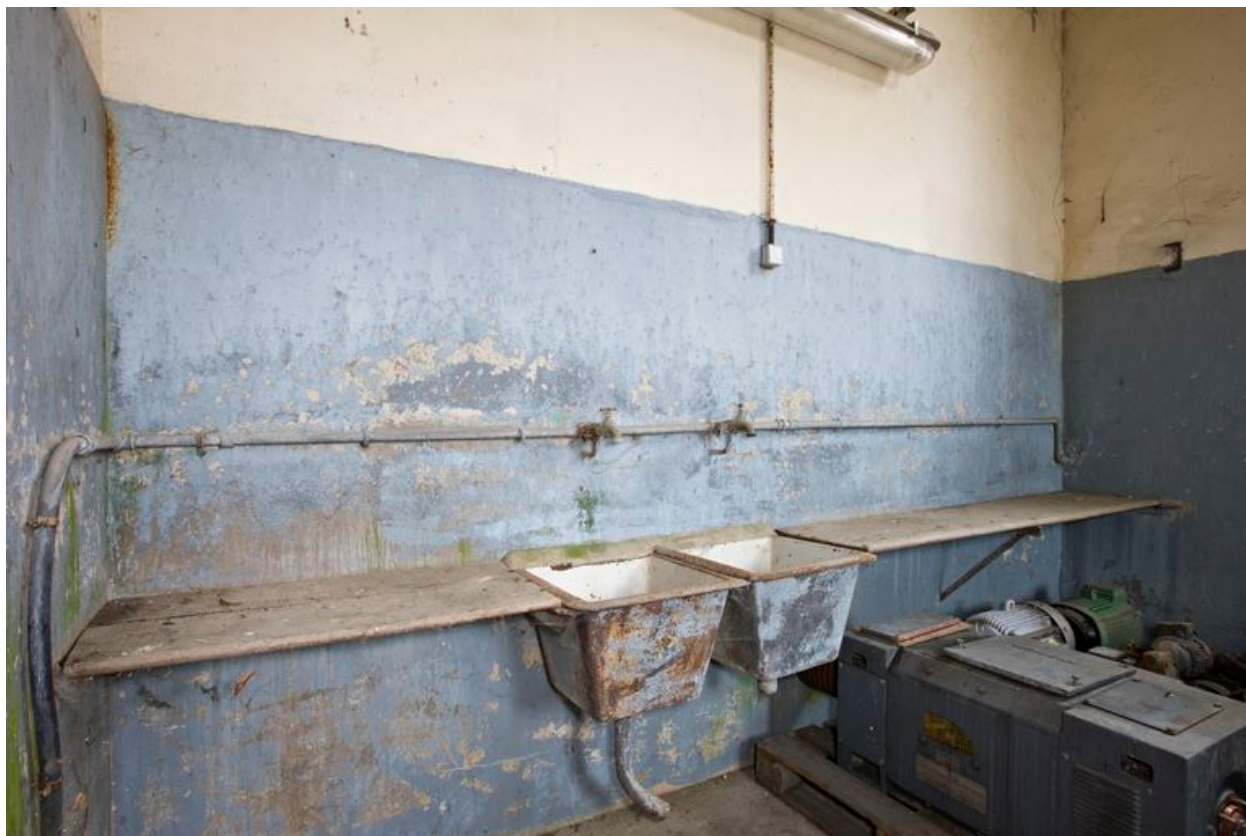
Bâtiment principal, la charcuterie : les évier.
