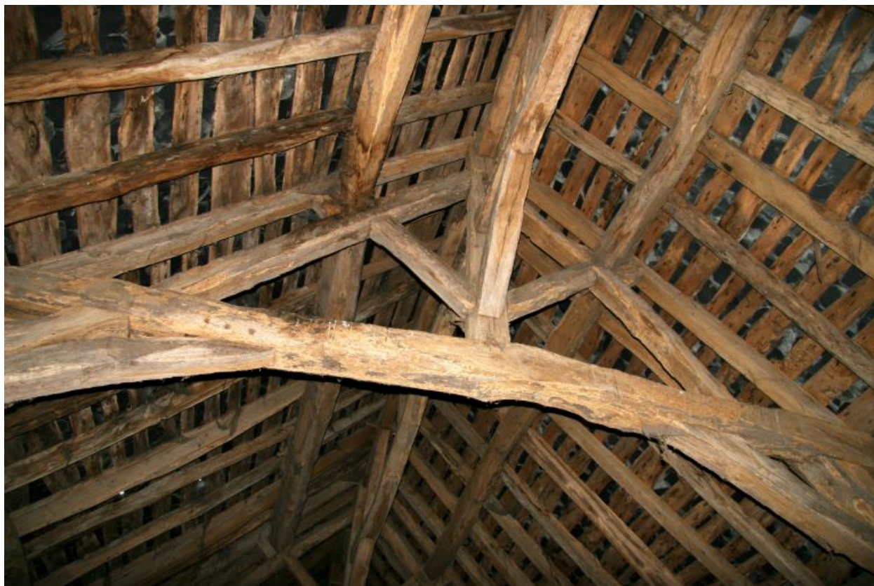
Grange-étable : charpente, détail.
