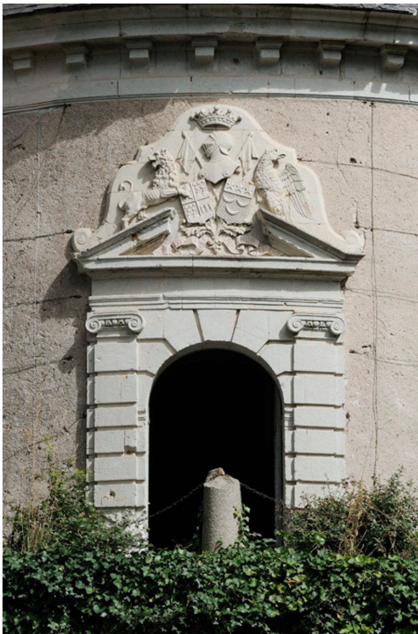
Porte de la chapelle. Fronton entrecoupé. Armoiries et ornements.
