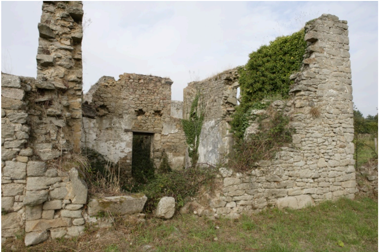
Logis. Aile sud. Pignon est.
