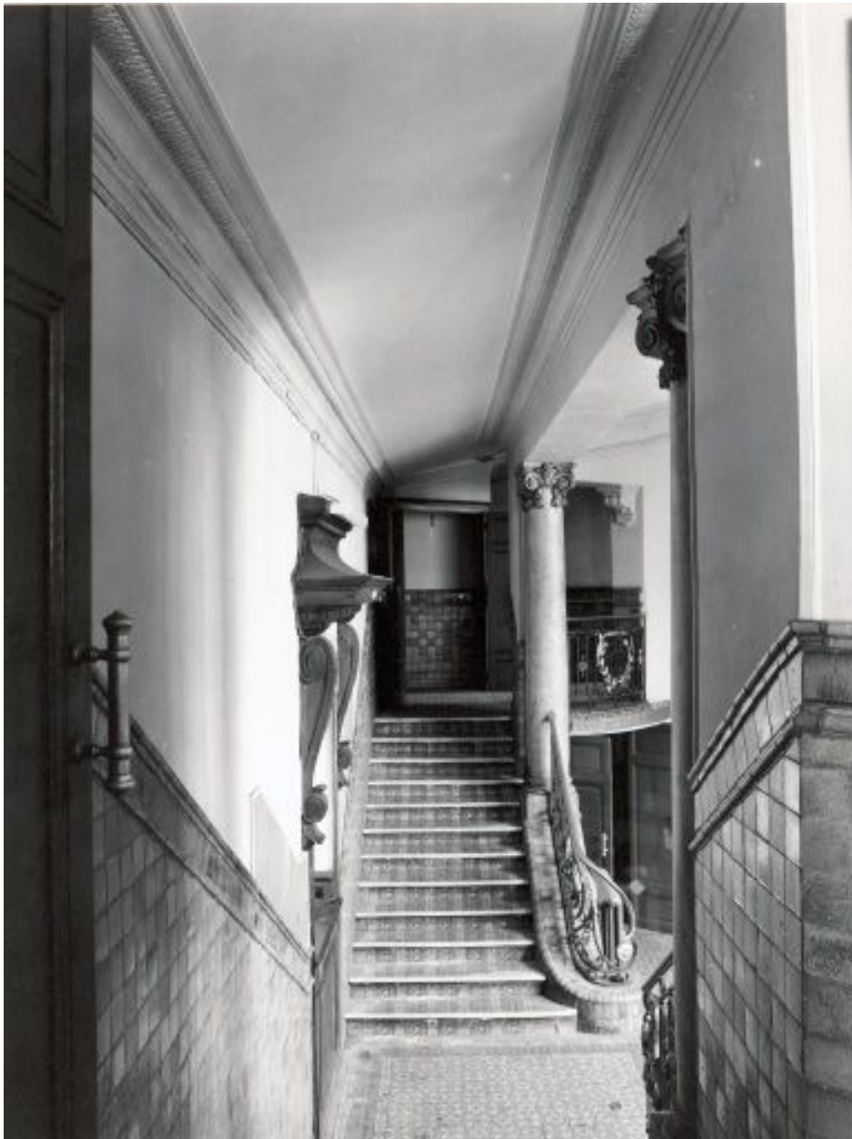
Cage de l'escalier d'honneur.
