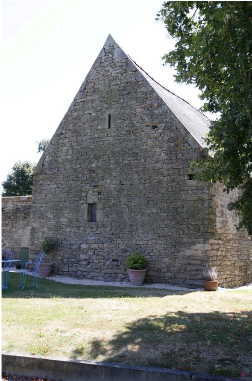
Bâtiment ouest. Vue du pignon nord.
