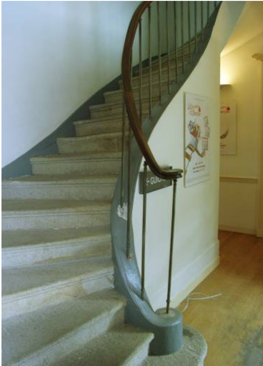
Vue de l'escalier depuis le rez-de-chaussée.
