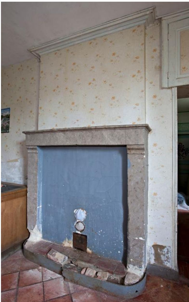
Maison, chambre 1 : cheminée.
