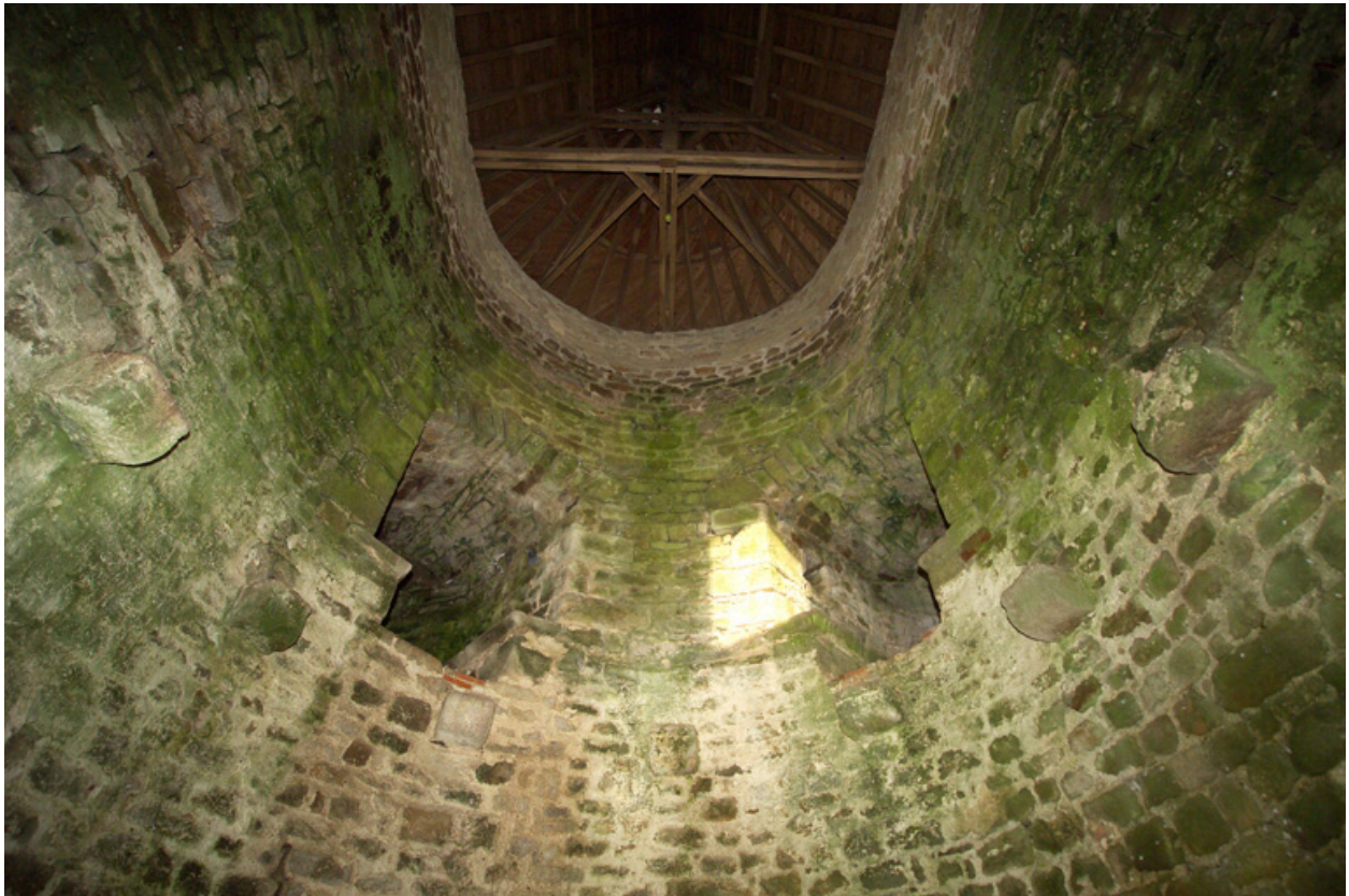
Élévation interne, premier étage.
