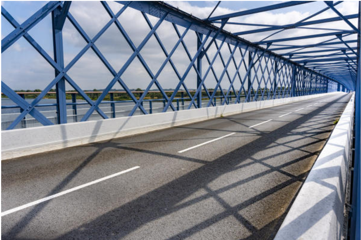
Vue de détail de la chaussée.
