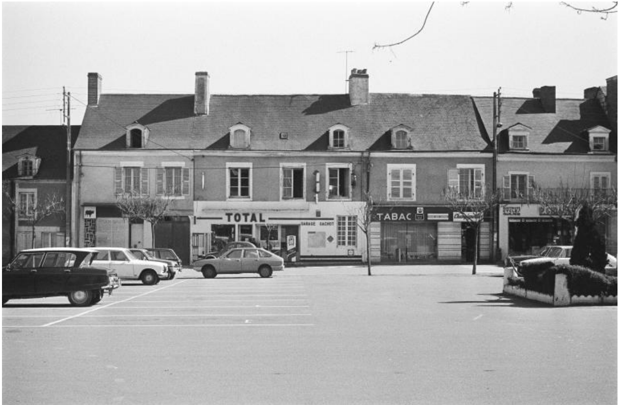
Vue d'ensemble, façade nord.
