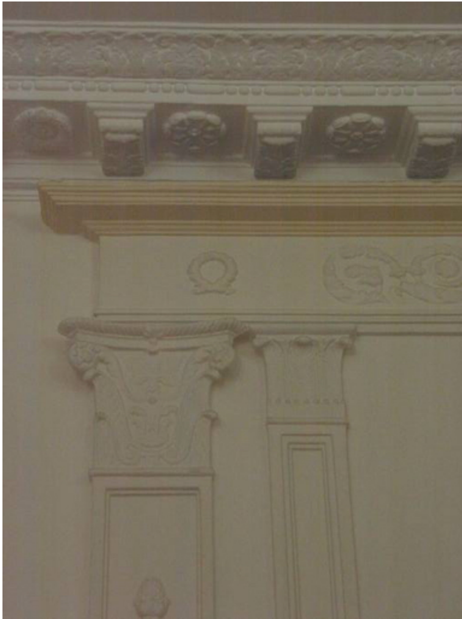
Détail du trumeau de cheminée et de la corniche du salon est au rez-de-chaussée.
