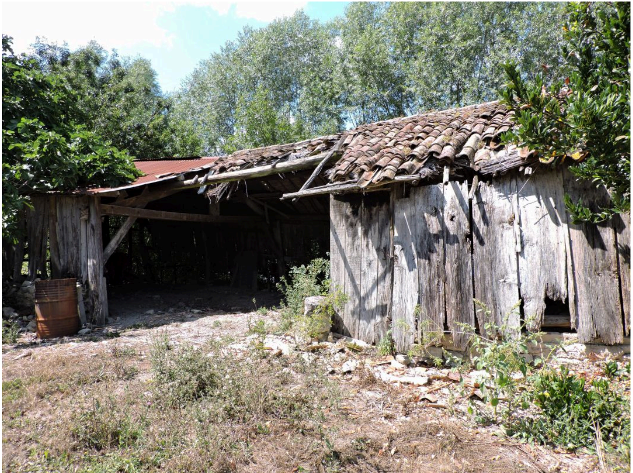
La grange-étable en bois dans le prolongement ouest du logis, vue depuis le sud-est.
