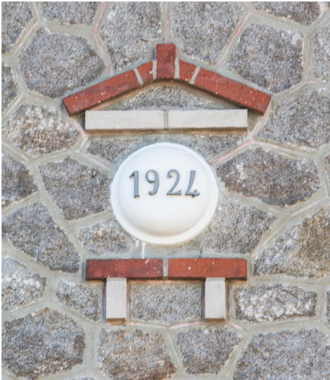
Maison, 83 rue Joseph-Tahet. Détail de la date portée.
