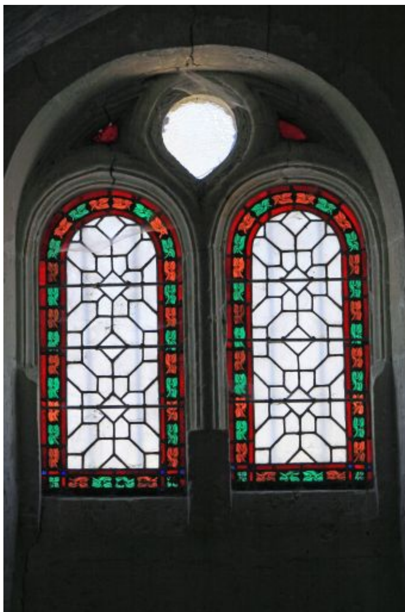
Baie 100 : vue générale.
