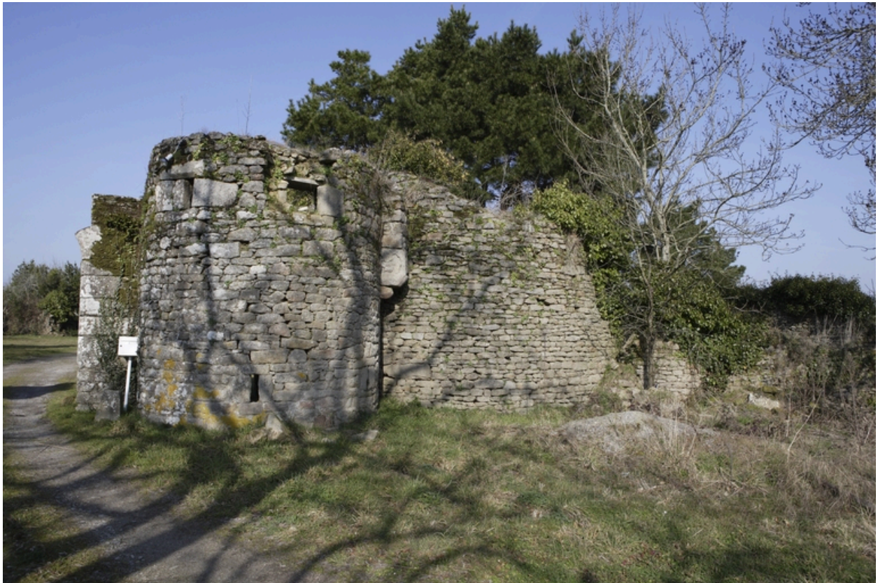
Portail d'entrée. Vue de la tour nord et du pigeonnier.
