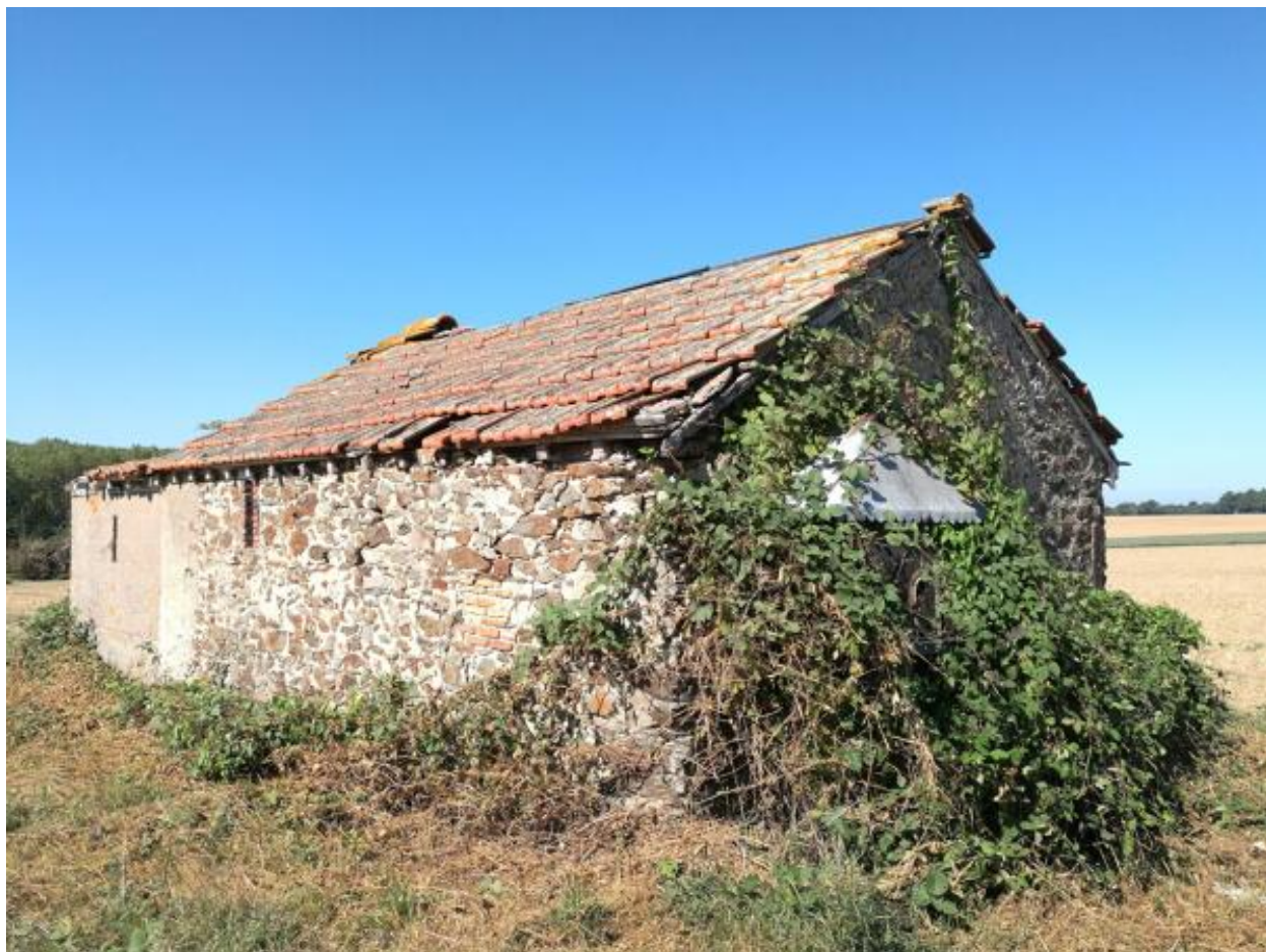
La Lançonnière. Ferme, 3e quart 19e siècle.
