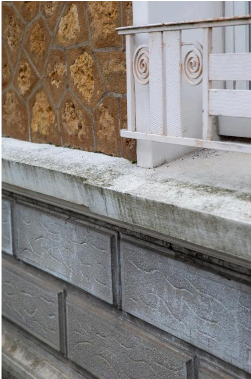
Un détail du solin, du parement et des ferronneries.
