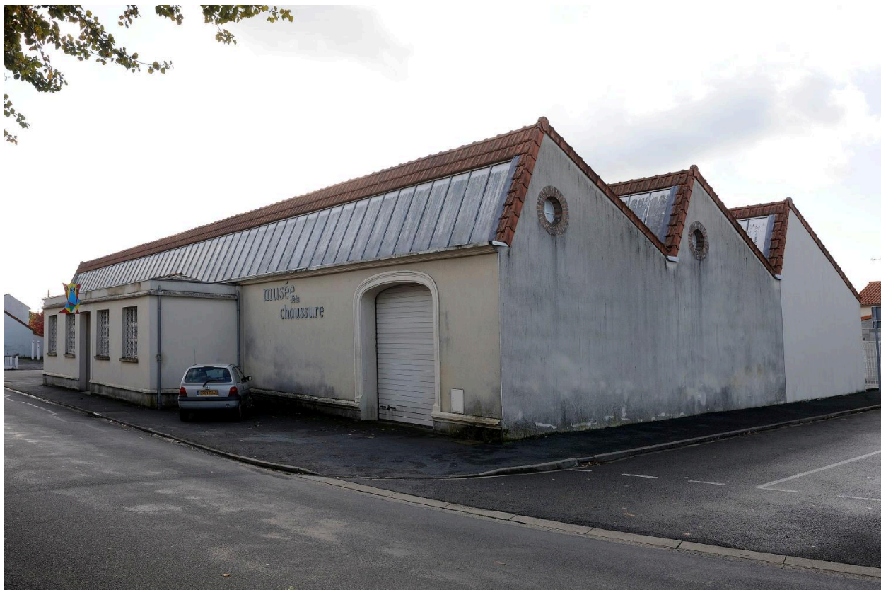
Vue générale de l'usine Ripoche, anciennement Morinière.
