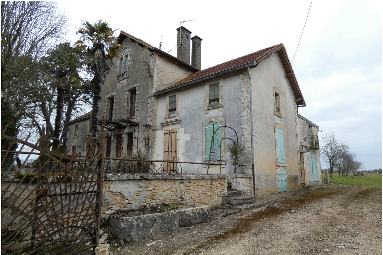
Le logis vu depuis le sud-est.
