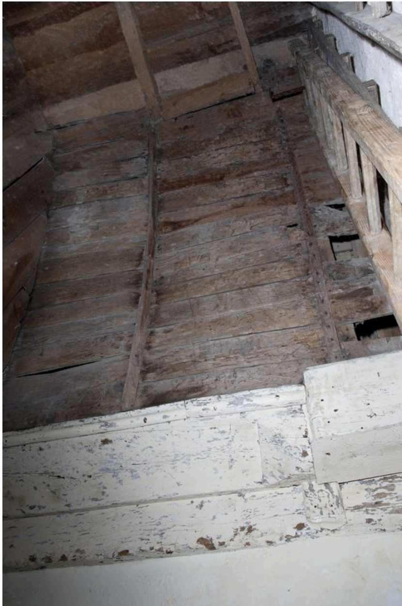
Partie conservée du lambris, située dans la cage d'escalier de la tribune.
