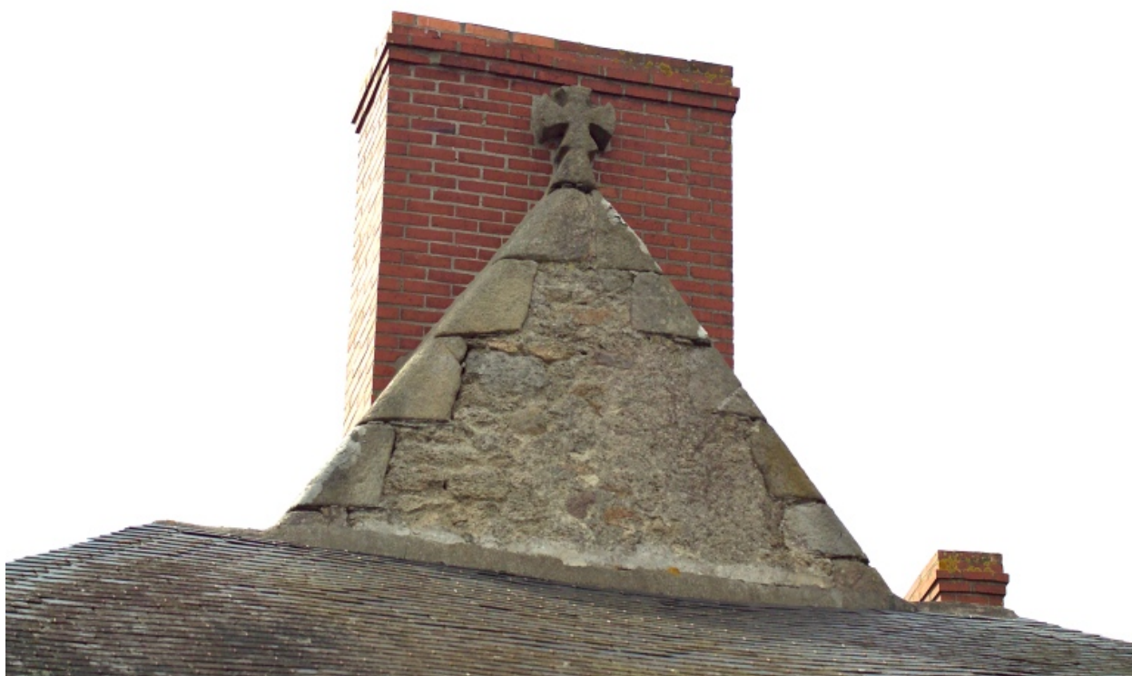
Pignon est, détail.
