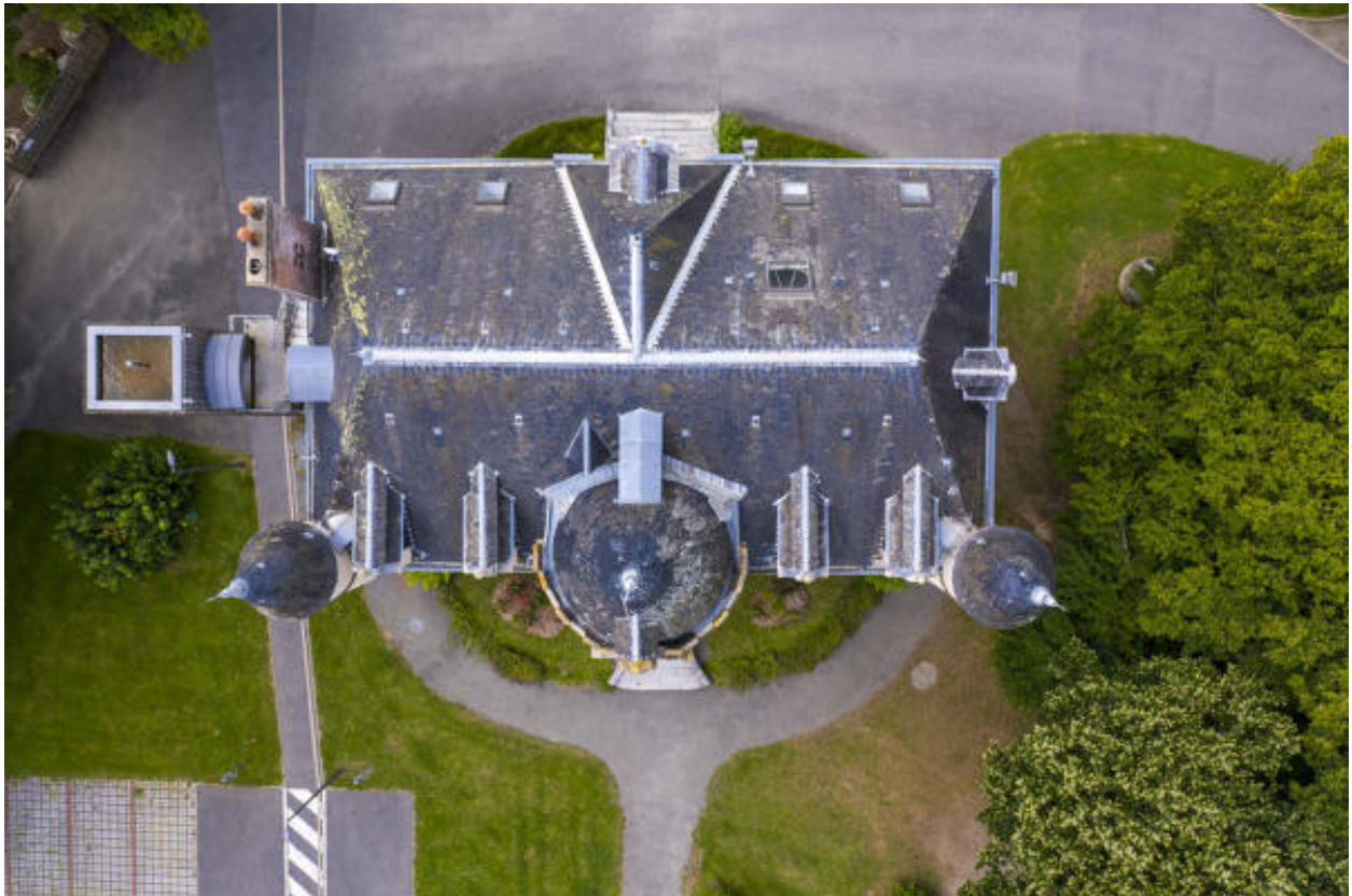
Une vue aérienne des toits du château.
