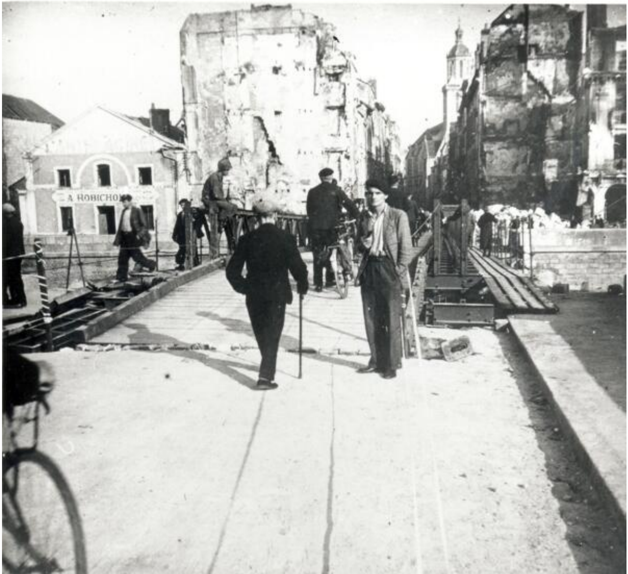
La passerelle aménagée par les Américains sur les arches du pont rive droite, vue de la chaussée vers la Doure, fotogr., 1944. (Coll. part. Michel Lemesle).
