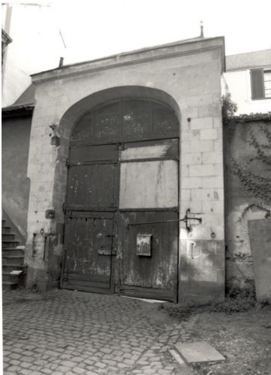
Portail : élévation postérieure.
