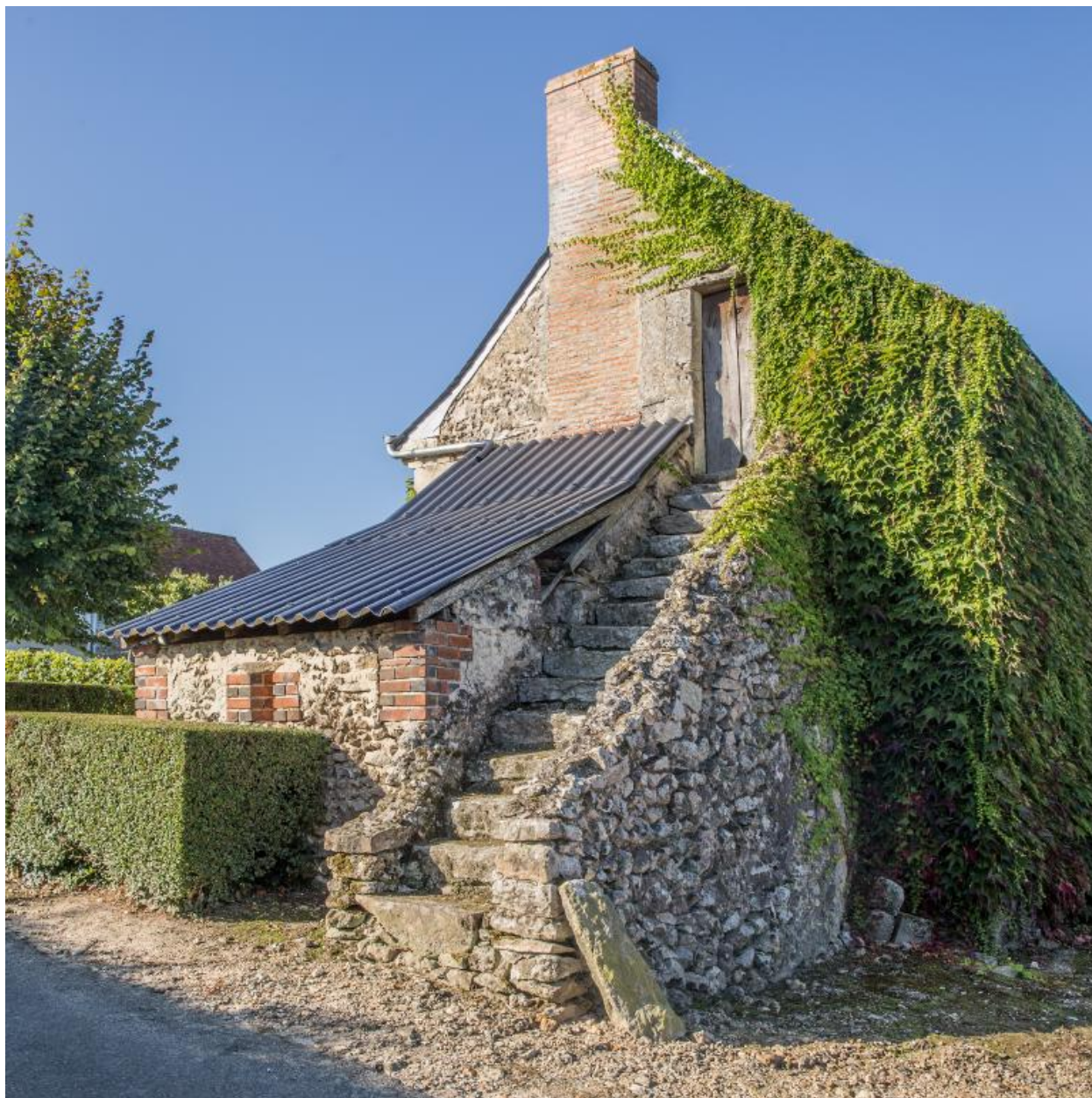
Ferme 1, détail : escalier en pierre menant au comble du logis.
