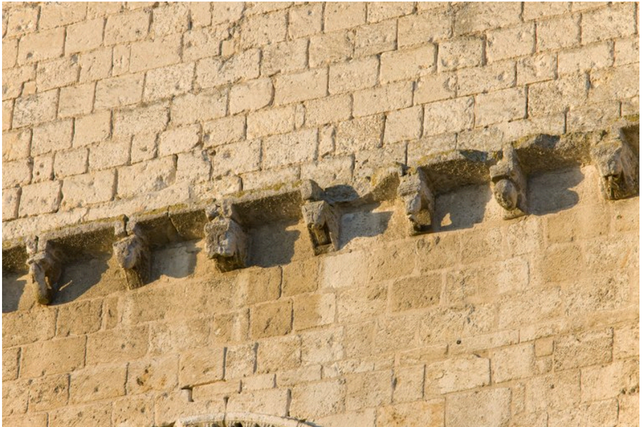
Façade du bras nord du transept : partie gauche de la frise de modillons.
