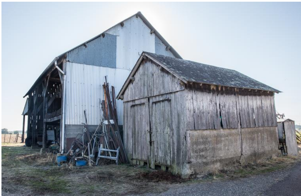
Ferme 2, remise et hangars agricoles à structure en bois.
