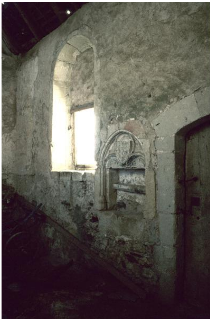
Choeur, mur sud : état avant travaux. Photographie de Jean Moreau, fin des années 1980.
