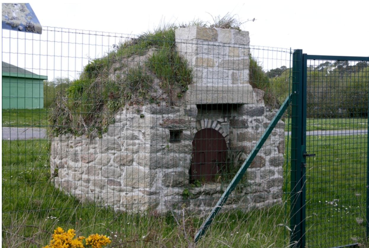
Vue du four à pain.
