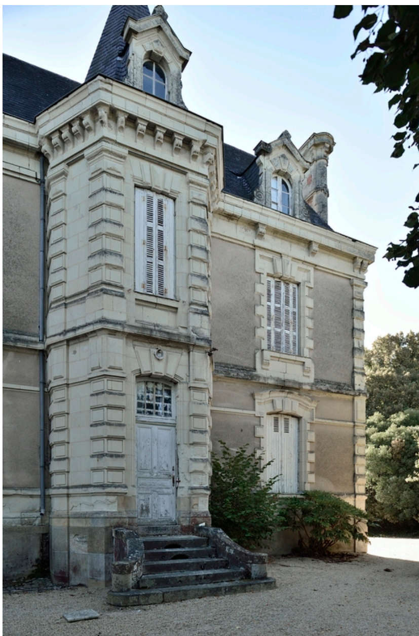
Détail de la façade occidentale.
