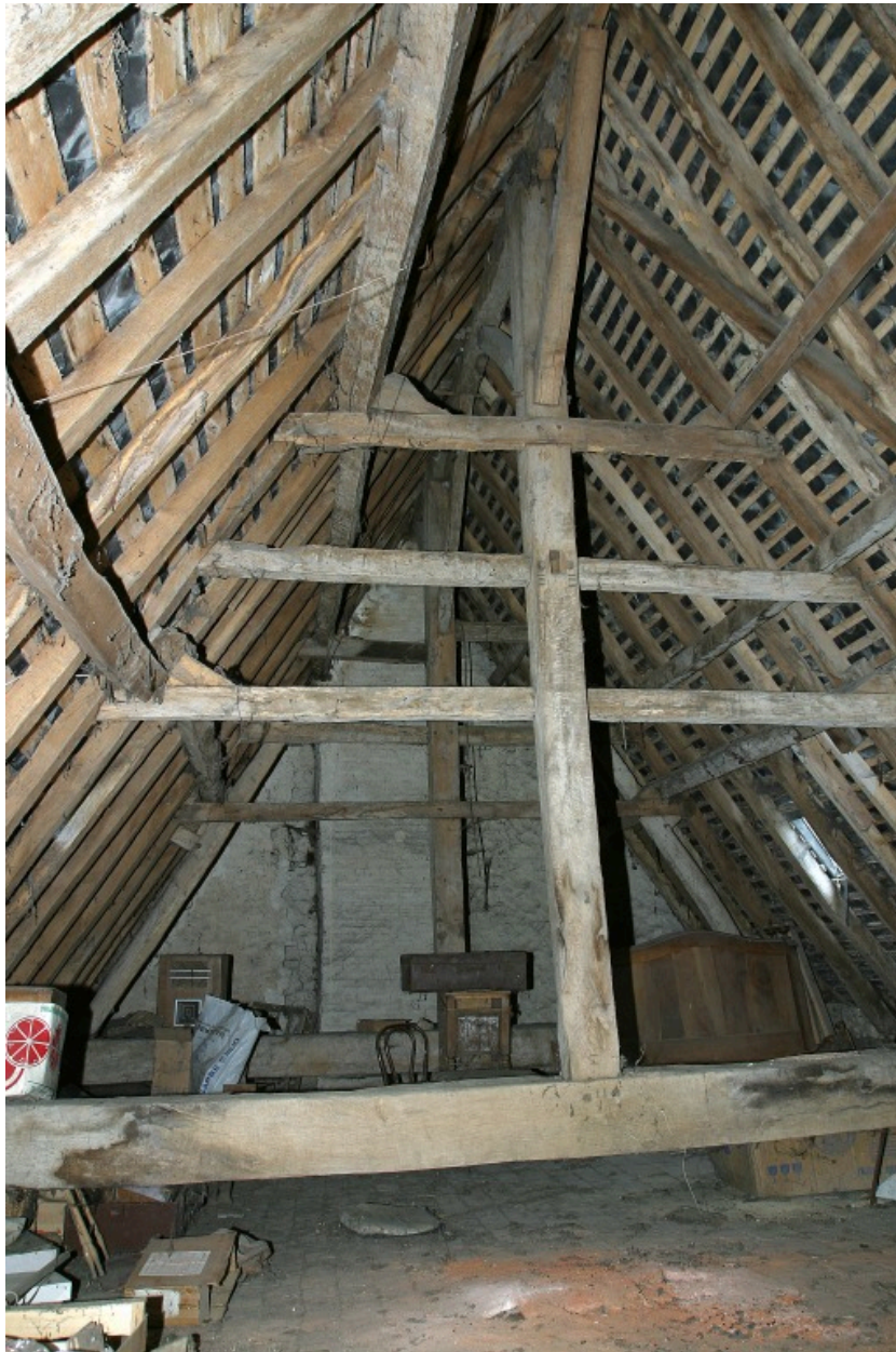
Le corps central, comble : la charpente vue depuis l'est.
