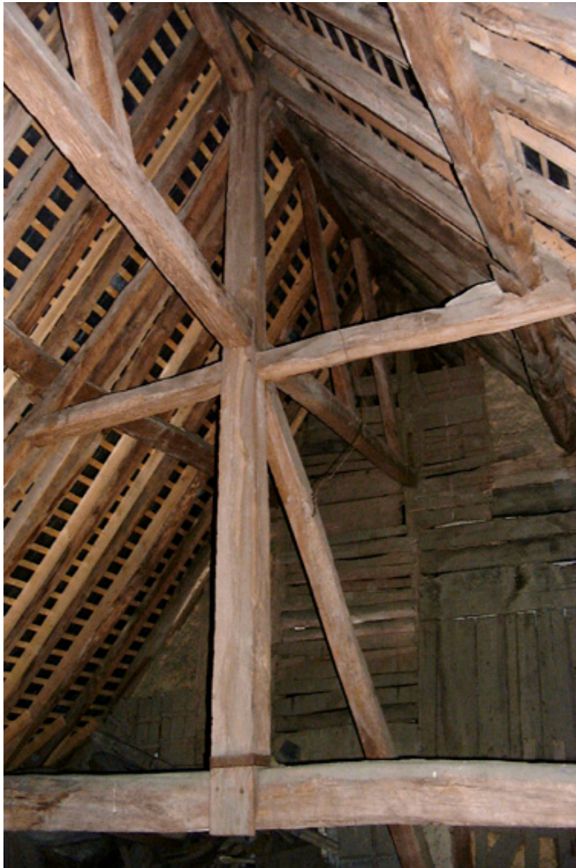
Détail de la charpente.
