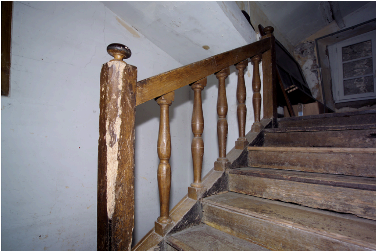
L'escalier, la volée d'accès à l'étage de comble.
