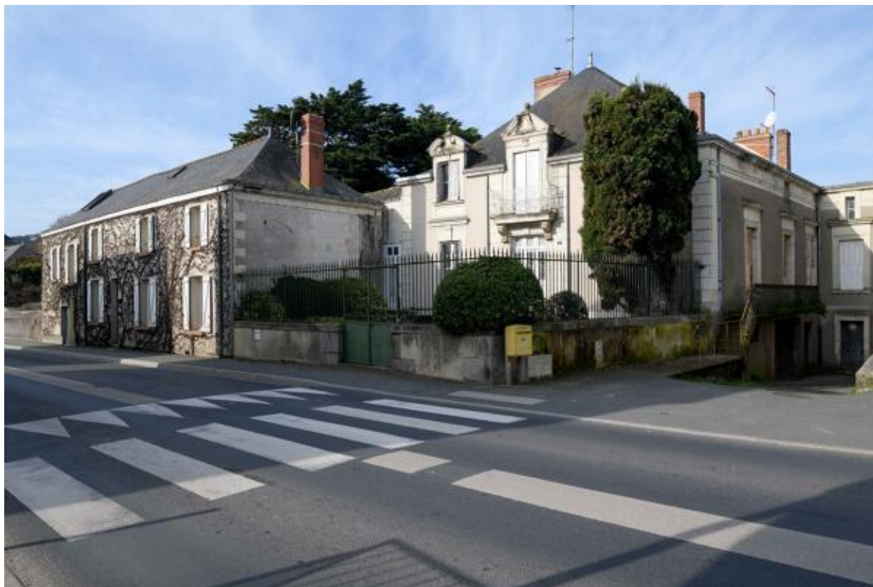
Vue d'ensemble du 2 et 4 rue d'Anjou.
