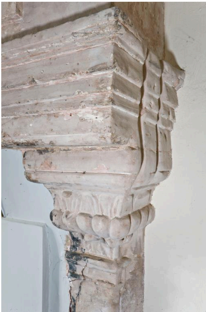
Maison, rez-de-chaussée, pièce à feu ouest : détail du linteau et corbeau droit.
